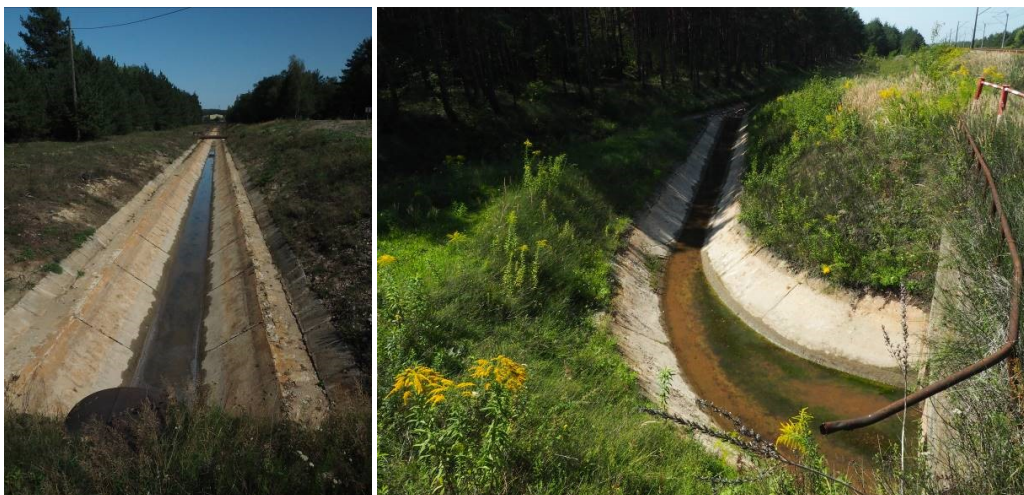
Kanał Południowy uchodzący do Baby (prawe) po zaprzestaniu pompowania wód dołowych w kopalni „Olkusz-Pomorzany” został wyczyszczony z nagromadzonych osadów i znajduje się aktualnie w dobrym stanie sanitarnym, spływają nim jedynie wody opadowe (10.08.2022) fot. A. Tyc
