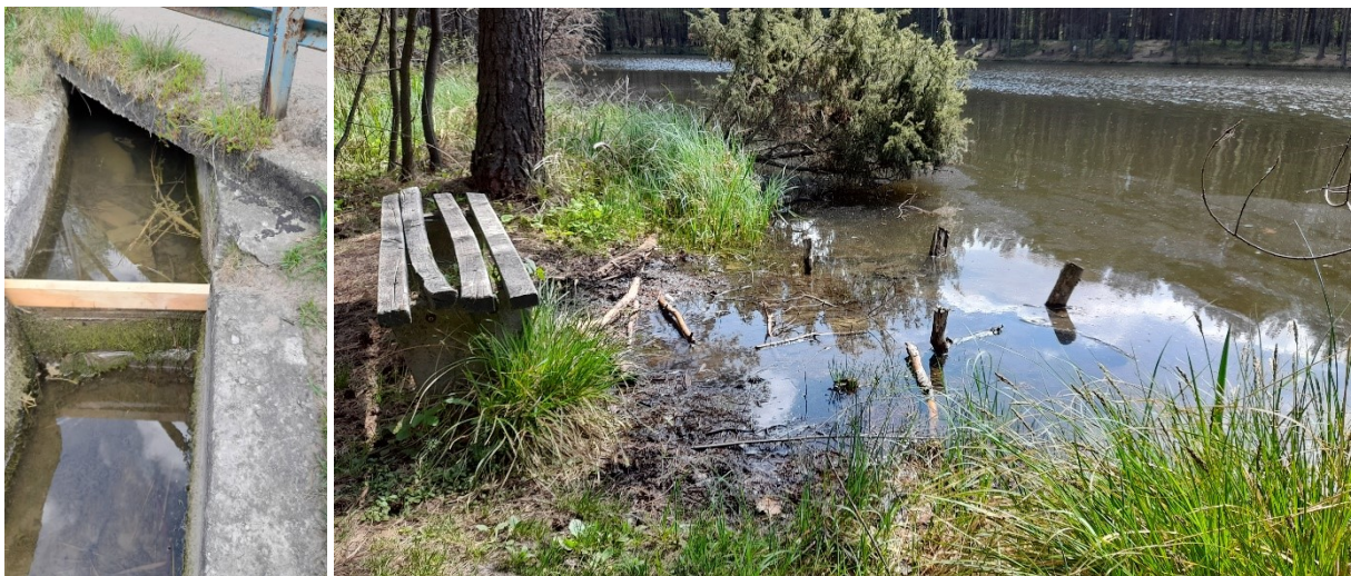
Dołożona deska piętrzenia wody na odpływie ze stawu przy Leśnym Dworze (lewe) oraz stan napętnienia wodą stawu wykorzystywanego do rekreacji wędkarskiej w Laskach (trzeciego od końca, prawe) (23.04.2022) fot. A. Czyłok
