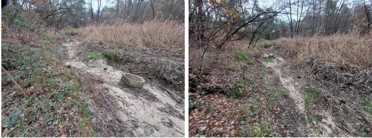
Oczyszczony ze śmieci odcinek Sztoły na wysokości ul. Reymonta w Bukownie, ten sam który został przedstawiony na fotografiach powyżej, 10.11.2024, fot. A. Tyc
