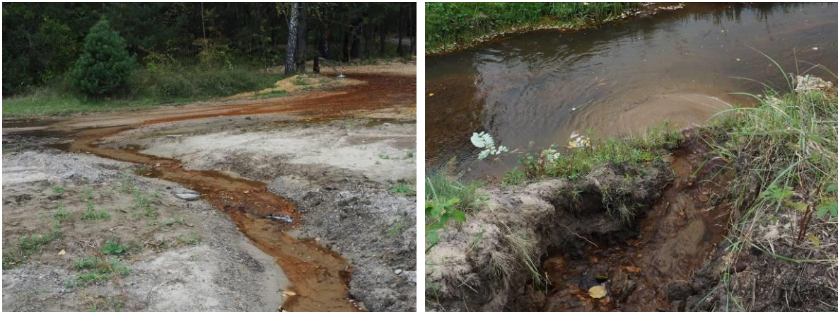
Strumień wody lejącej się z otworu badawczego przy moście drogi z Lasek do Błędowa skierowany do Białej prowizorycznym przekopem (lewe) oraz stożek piasku usypany przy ujściu przekopu do Białej (prawe), 27.09.2024, fot. A. Tyc
