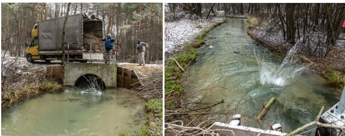
Fot. 7 i 8. Splewanie biomasy na Sztole przy moście Cesarskiego Gościńca fot. M. Stobierski (9.12.2021)
